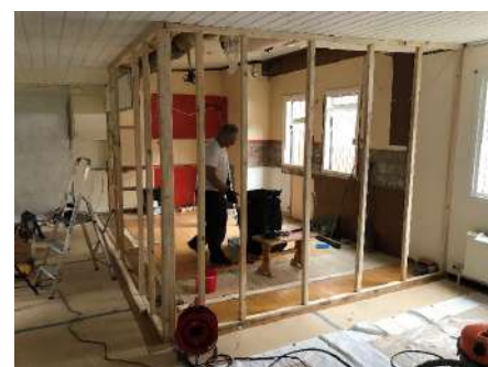
Bygge av väggar
