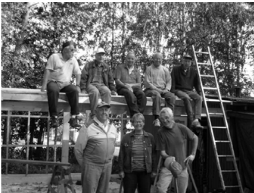
Bygggänget som snickar på det nya förrådet vid LOK-gården. Bild: Rune Fritz
